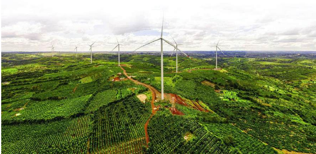
Dự án điện gió tại Đắk Nông
